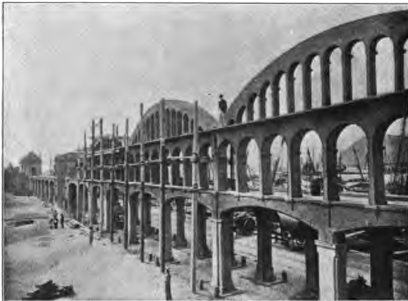
Abb. 66. Stirnseiten der Hafenspeicher in Barceloneta (Spanien).
